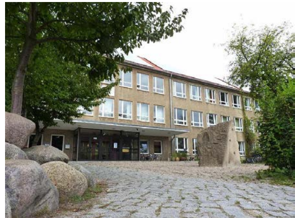
Abb.1: Die Montessori-Oberschule in Potsdam; Außenansicht
